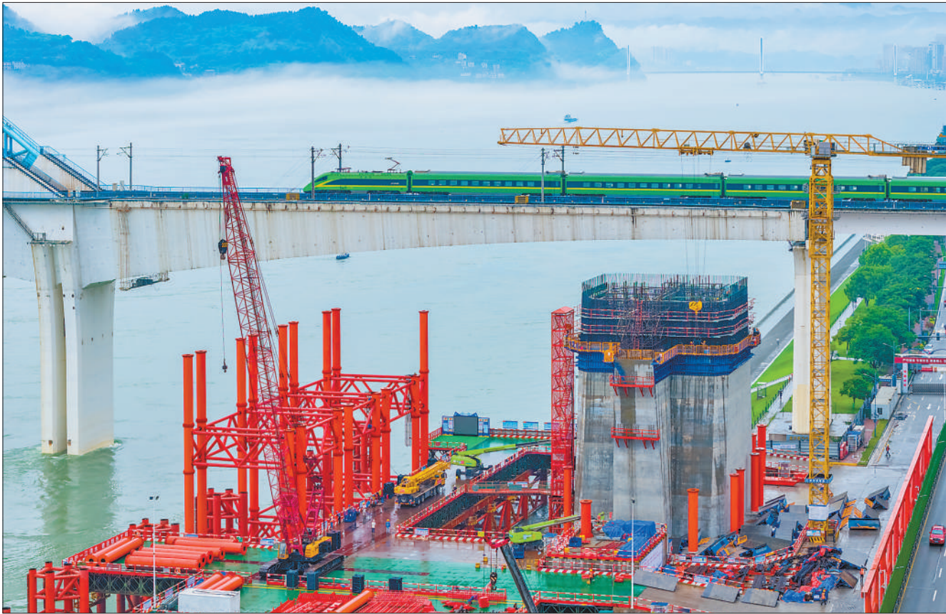
5月26日,湖北宜昌长江公铁大桥建设现场机器轰鸣,一派繁忙景象。大桥采用铁路在上、公路及轨道交通在下的分离式钢桁梁斜拉桥结构,创新应用独柱式组合主塔设计。这座大桥与既有宜万铁路大桥并行,是沪渝蓉沿江高铁宜涪段的关键控制性工程。 王 耿摄(影像中国)
